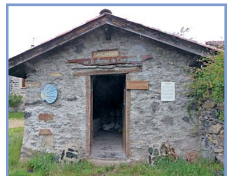
Ein ehemaliger Backofen dient nun zum Unterstellen
